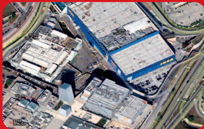
Cantiere Porte di Roma, Via delle Vigne Nuove
