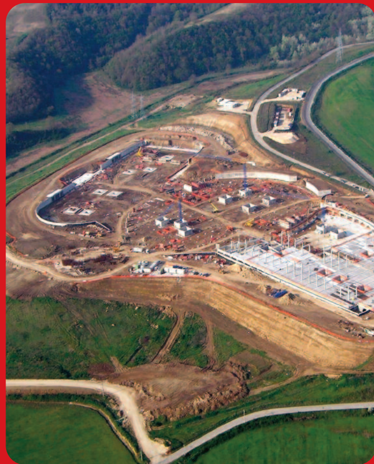
Cantiere Soratte Outlet shopping, Sant'Oreste, Roma
