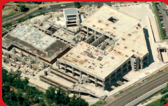
Cantiere nuovo stabilimento I.P.Z.S., Via di Villa Spada, Roma
